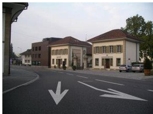
Pförtnerhäuser an der Dorfstrasse
