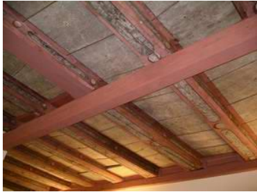
Decke im Foyer
